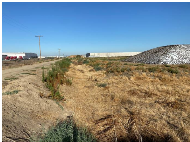
13. Final stage effluent pond.
